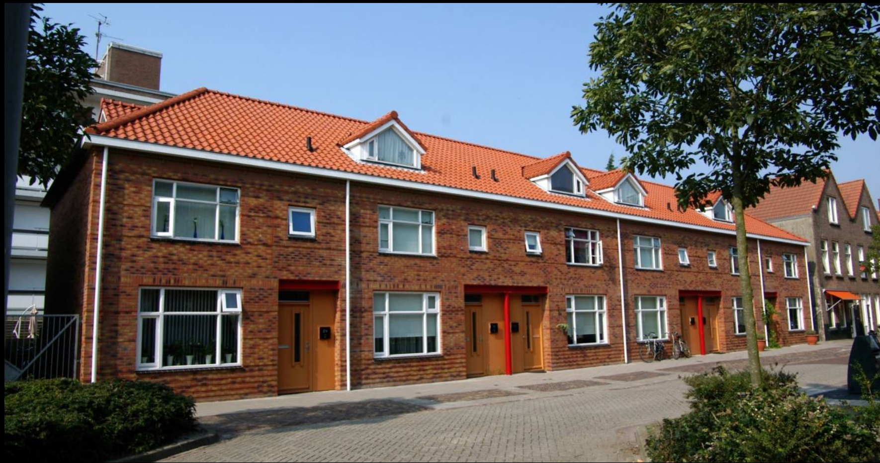
eengezinswoningen verkuijl quakkelaarstraat vliissingen
