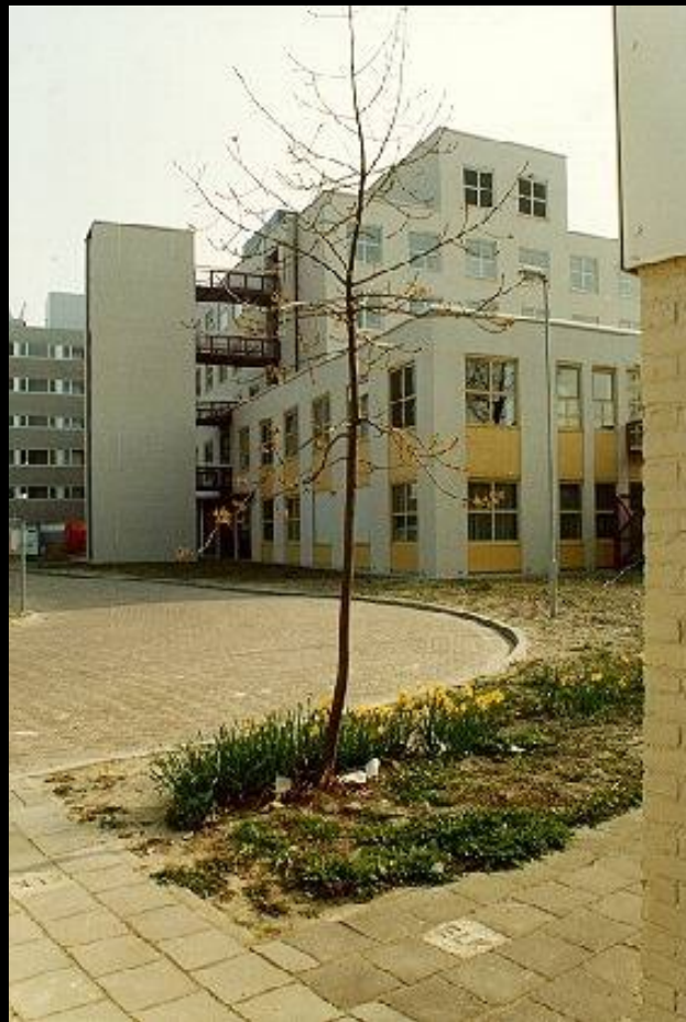
ziekenhuis walcheren vlissingen
