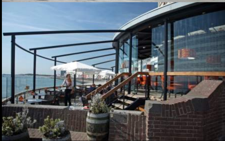
restaurant de gevangentoren vlissingen
