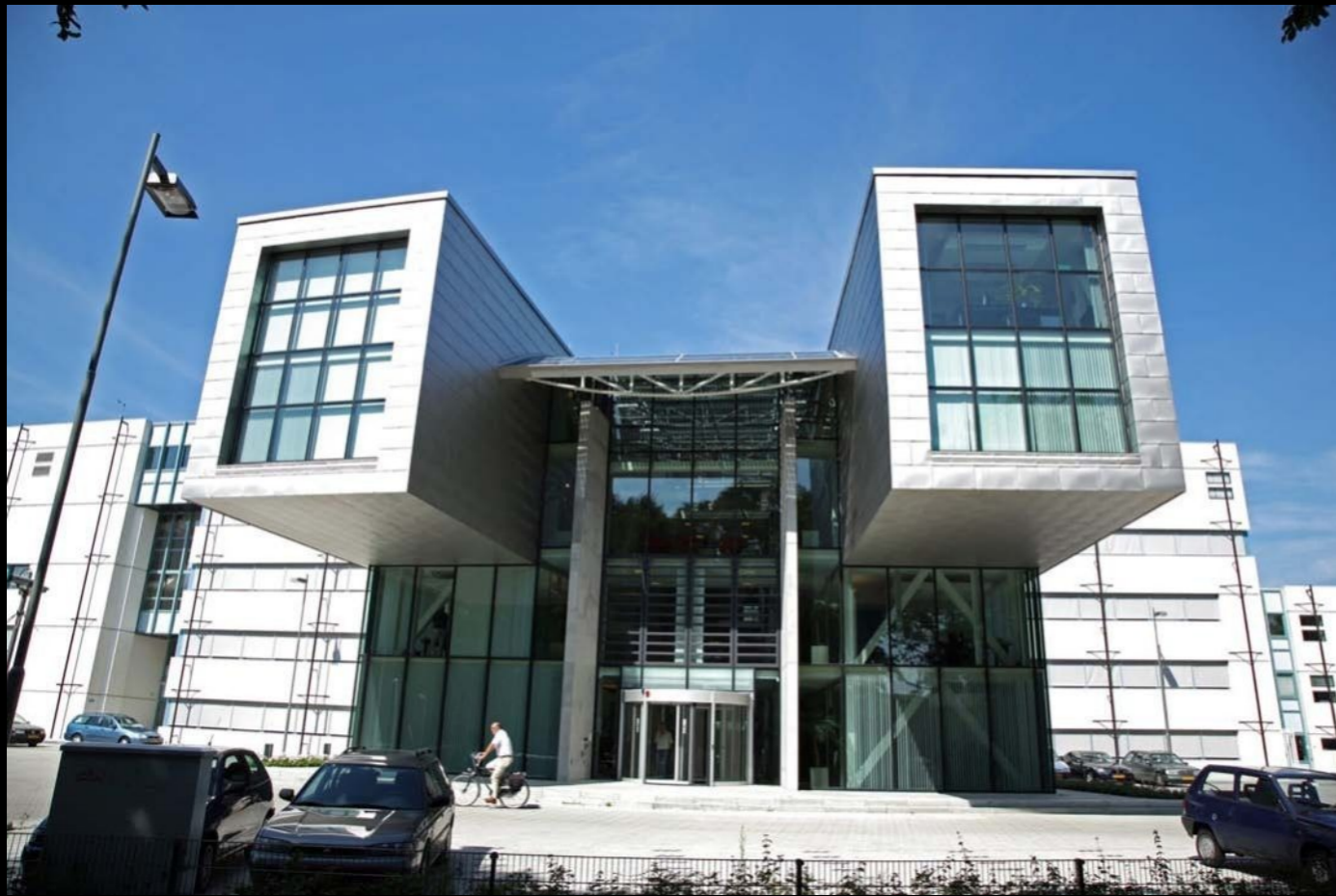
provincie kantoor rmw uitbreiding middelburg
